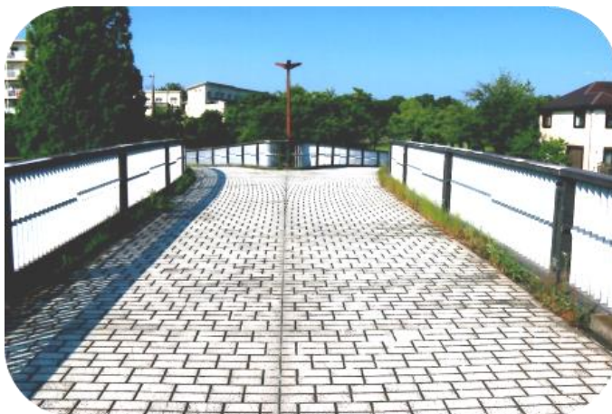
Y 字橋 ; 尾根幹線を跨ぐ Y 字橋で三方向からアクセス可能な橋。
